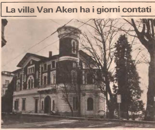
La caratteristica villa Van Aken, a Cassarate, ha ormai i giorni contati. Diventata proprietà del comune di Castagnola sta per essere demolita per consentire la creazione di un giardino pubblico che vuole essere un altro passo verso la realizzazione di una passeggiata continua fino al ponte del Diavolo.
